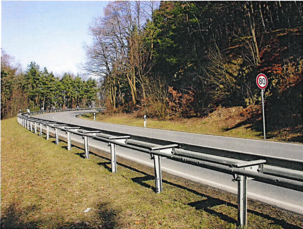
Abb. 1: Bei dieser Blickrichtung wird deutlich, wie durch den Straßenbau der Hang angeschnitten wird. Es handelt sich hier sicherlich nicht um einen ursprünglichen Felshang.
