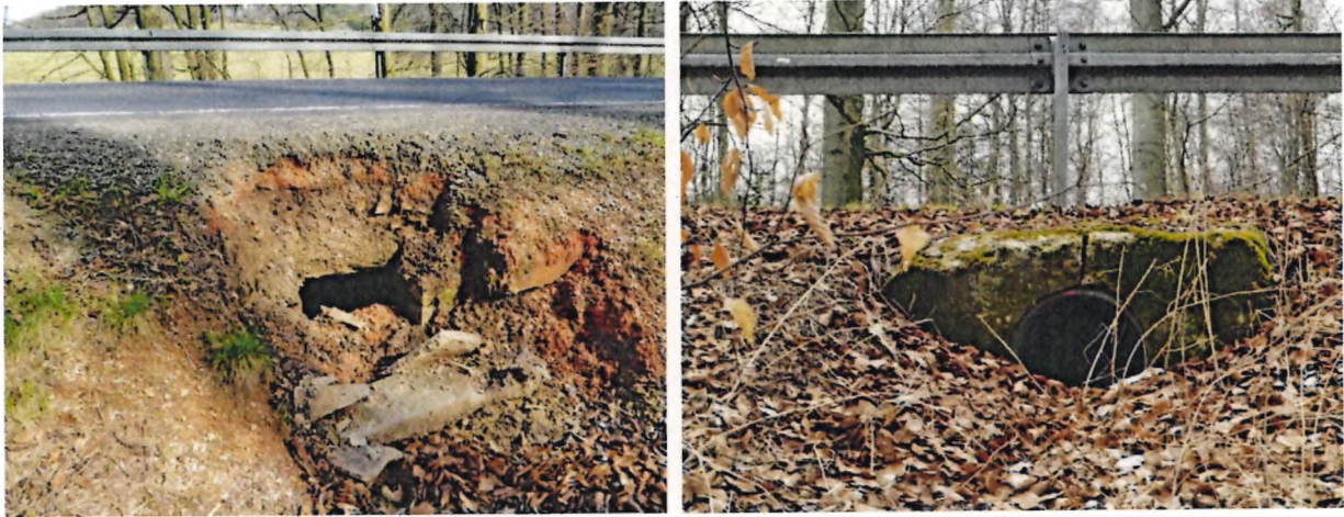
Abb. 5-1: Aufweitung des bestehenden Durchlasses westlich des Eschenhahner Sterns, der zurzeit als Unterquerung nicht passierbar ist (Fotos: O. Simon).
