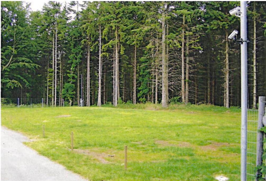
Abb. 6-2: Blick in ein Sensorfeld der östlichen Wildwarnanlage an der B 202 / Schleswig-Holstein. Nur im Bereich des 50 x 20 m großen Sensorfeldes wurden Bäume entfernt. (Foto: C. Trothe).
