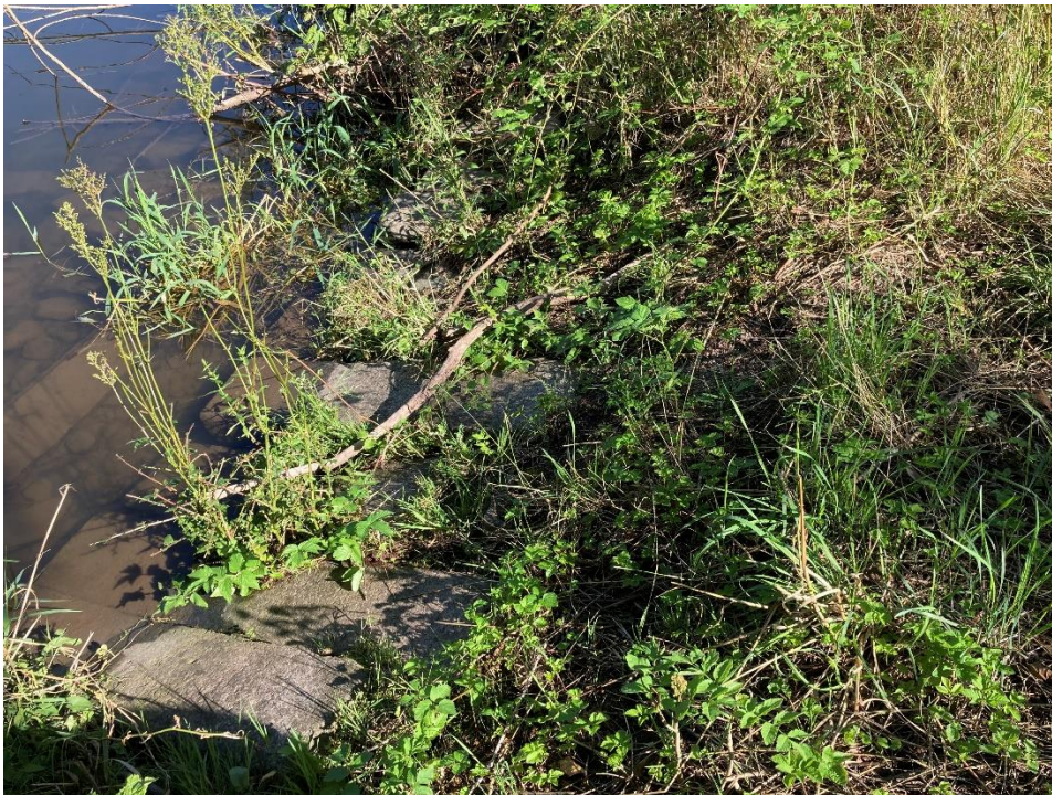
Abb. 3-1: Uferbereich der Fulda mit Uferbefestigung und angrenzend modelliertem Gelände
