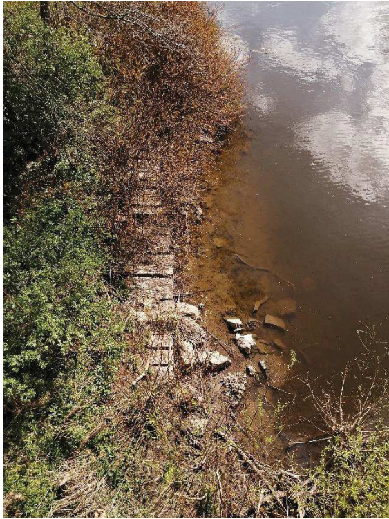
Abb. 3-1: Uferbefestigung am östlichen Fuldaufer.
