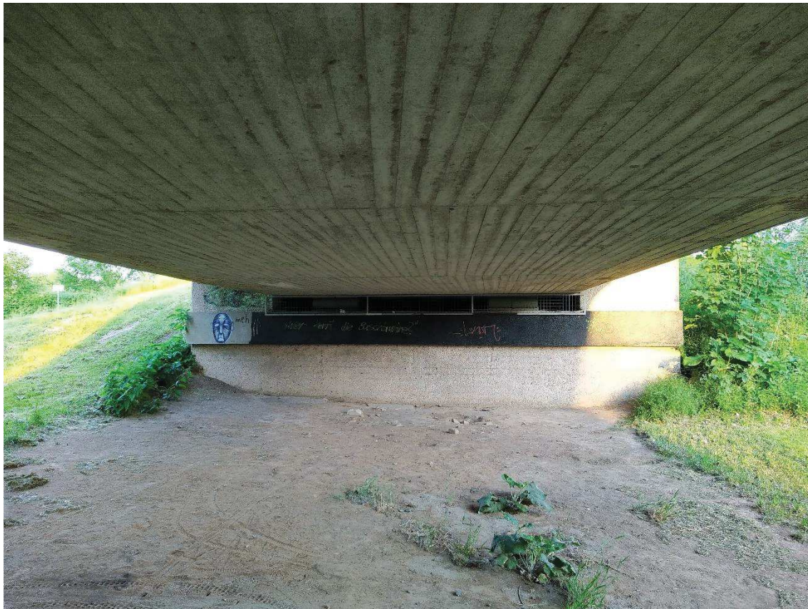
Abb. 7-3: Potenzielle Quartiermöglichkeit im Widerlager der Brücke
