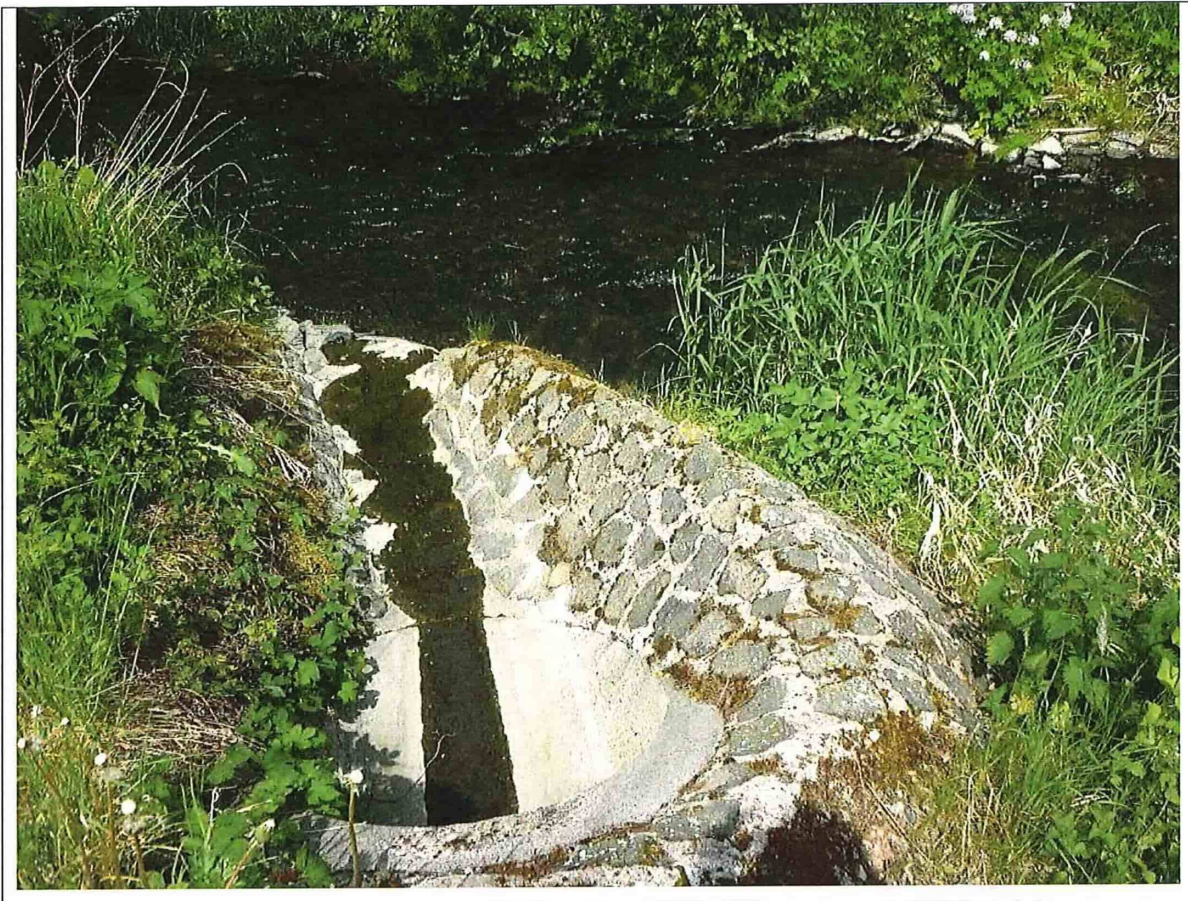
Abbildung 9: Einleitung der Straßen- und Rastanlagenabflüsse an der Döllbach-Talbrücke
