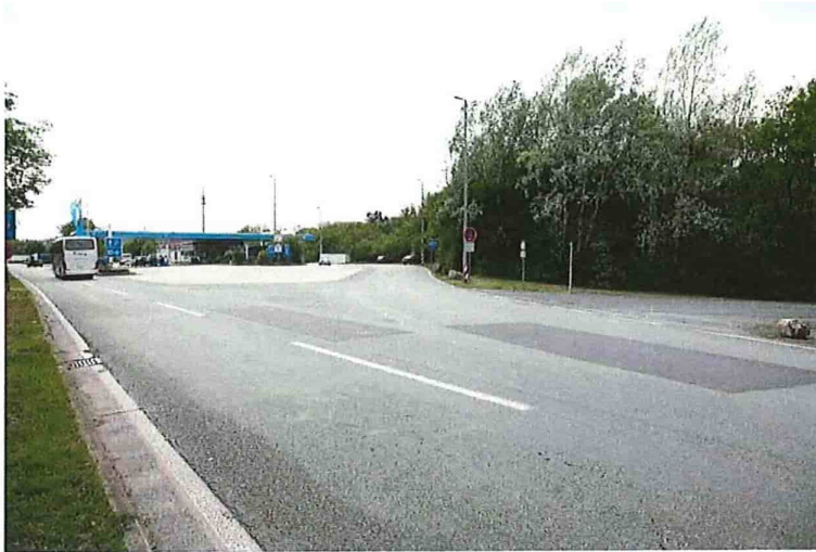
TR-Anlage West: Einfahrtsbereich zur Tankstelle
