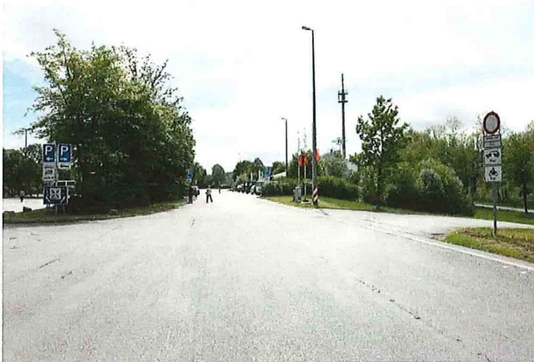
TR-Anlage West: Parkplatz mit Gehölzbiotopen - Blick auf das Rasthaus
