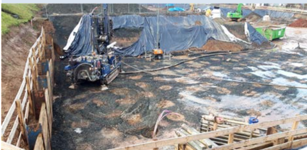
Bohrgerät in Aktion zur Installation der Erdwärmesonden
