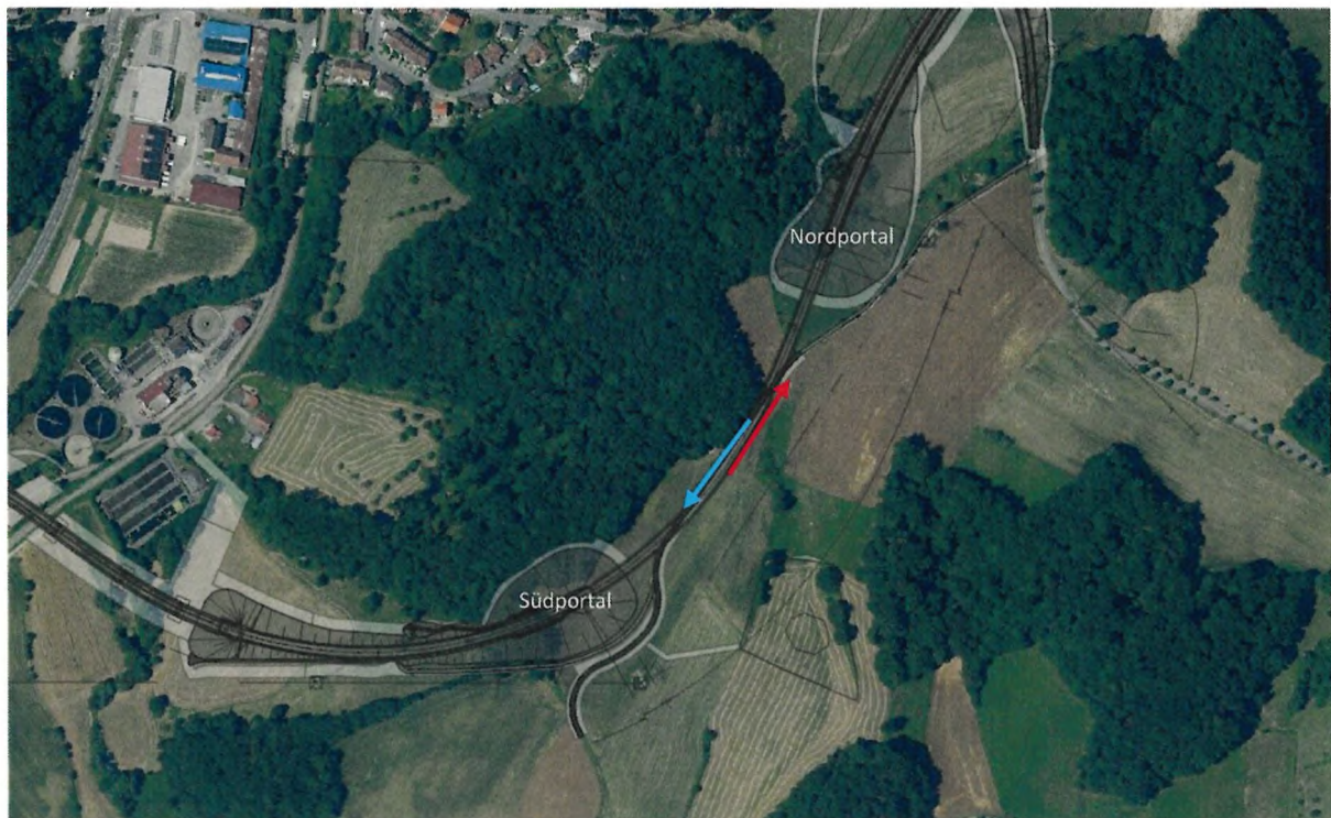
Abbildung 2: Dargestellt ist der Tunnel bei Berkersklamm. Der Kalottenvortrieb des Tunnelbaus erfolgt vom 01.11.2024 bis zum 31.03.2025 in einem 24 h Betrieb von Süden nach Norden (roter Pfeil). Ab dem 01.04.2025 beginnt der Ausbruch der Stosse und Sohle von Norden nach Süden (blauer Pfeil).
